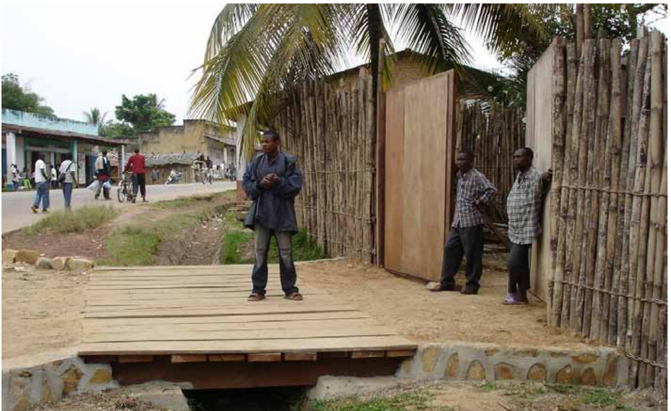
OPEN DRAINS / DRAIN OUVERT
