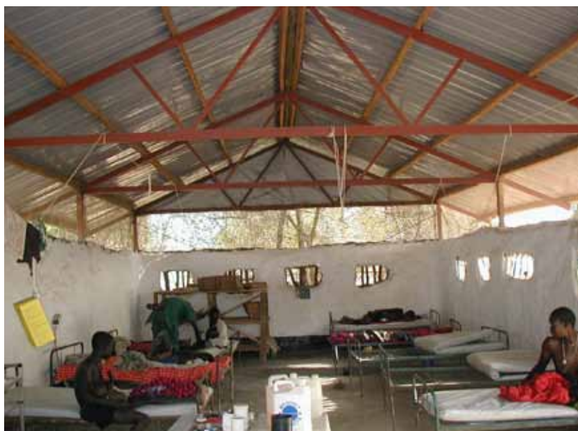
METAL-FRAMED STRUCTURE / STRUCTURE AVEC OSSATURE MÉTALLIQUE MSF, SUDAN
