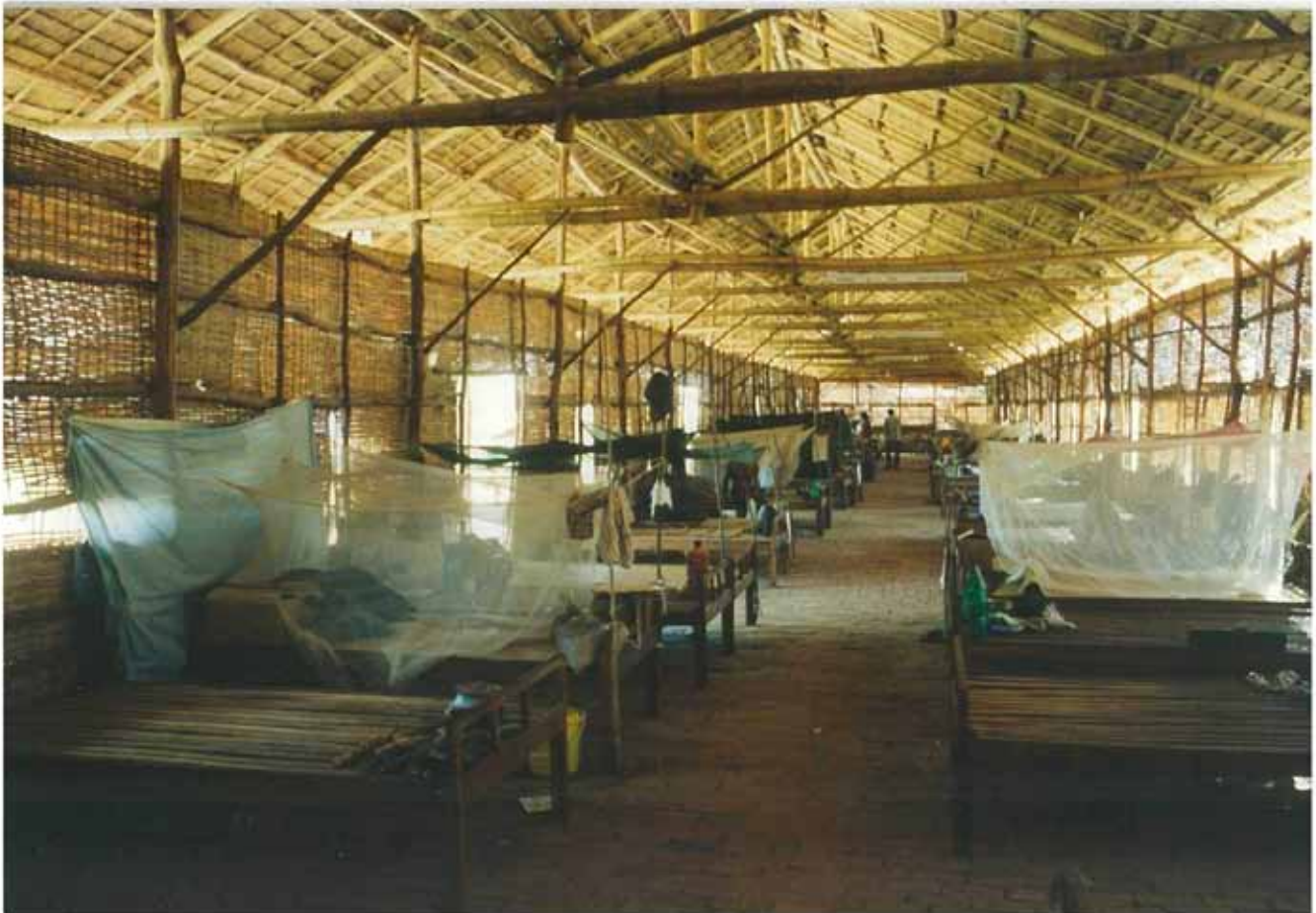
INPATIENT WARD MADE FROM A LITTLE WOOD AND MUCH BAMBOO / HOSPITALISATION RÉALISÉE AVEC PEU DE BOIS ET BEAUCOUP DE BAMBOU MSF, CAMBODIA
