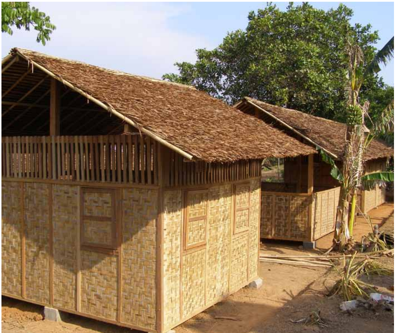
FIG 79, SHELTER MADE OF WOOD AND NATURAL FIBRE / ABRI FAIT DE BOIS ET DE FIBRE VÉGÉTALE MSF, MYANMAR
