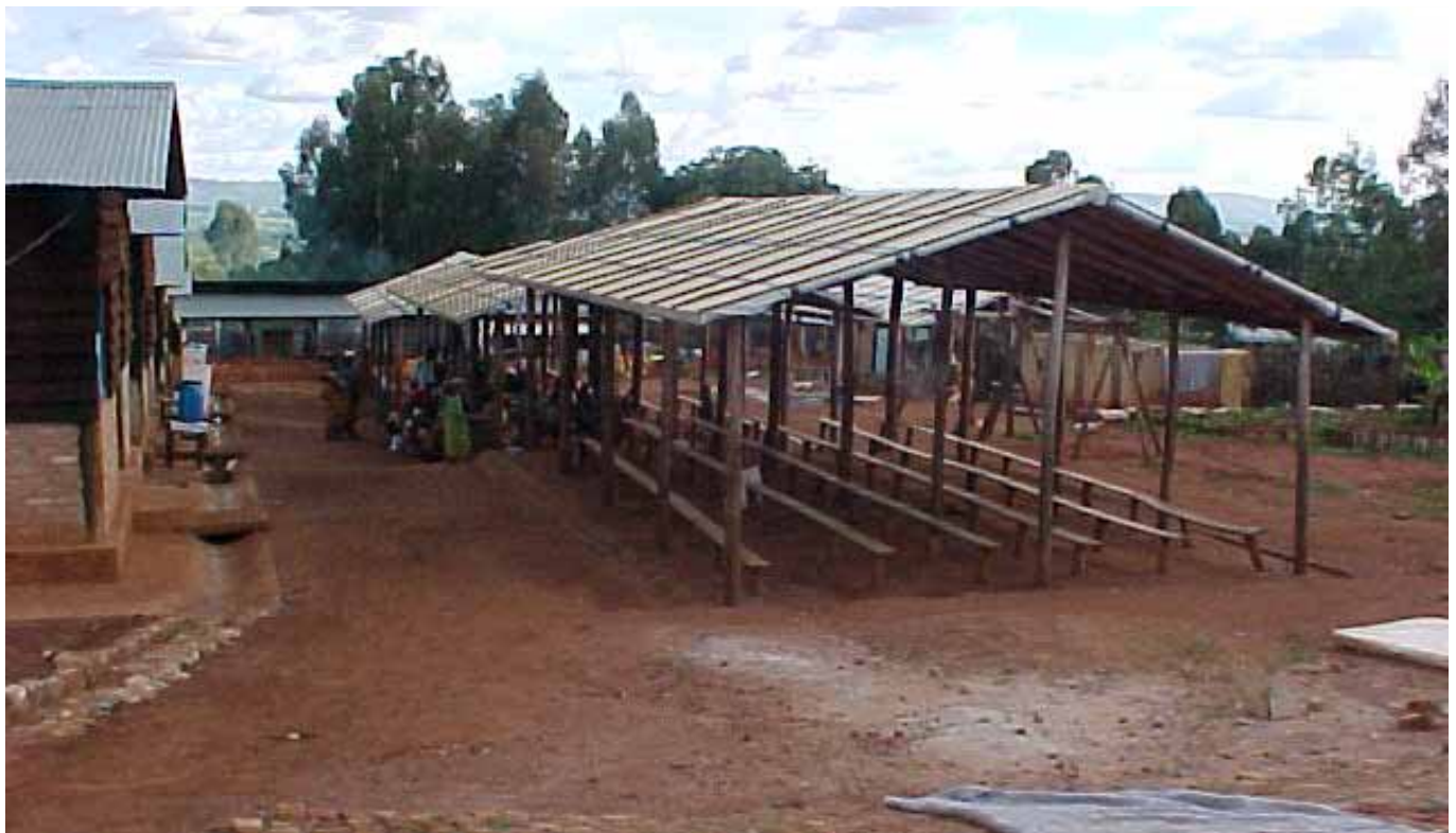
WAITING AREA COVERED WITH PLASTIC SHEETING / ZONE D'ATTENTE EN BÂCHE PLASTIQUE MSF, BURUNDI
